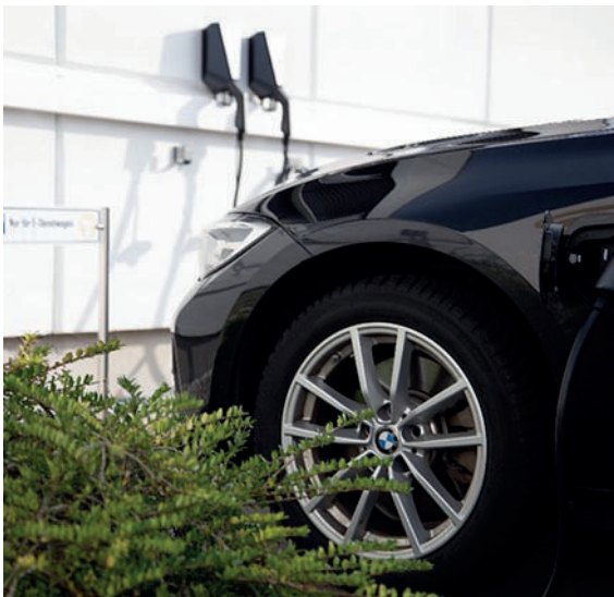
Ladeinfrastruktur bei der Thomas GmbH Deutschland
